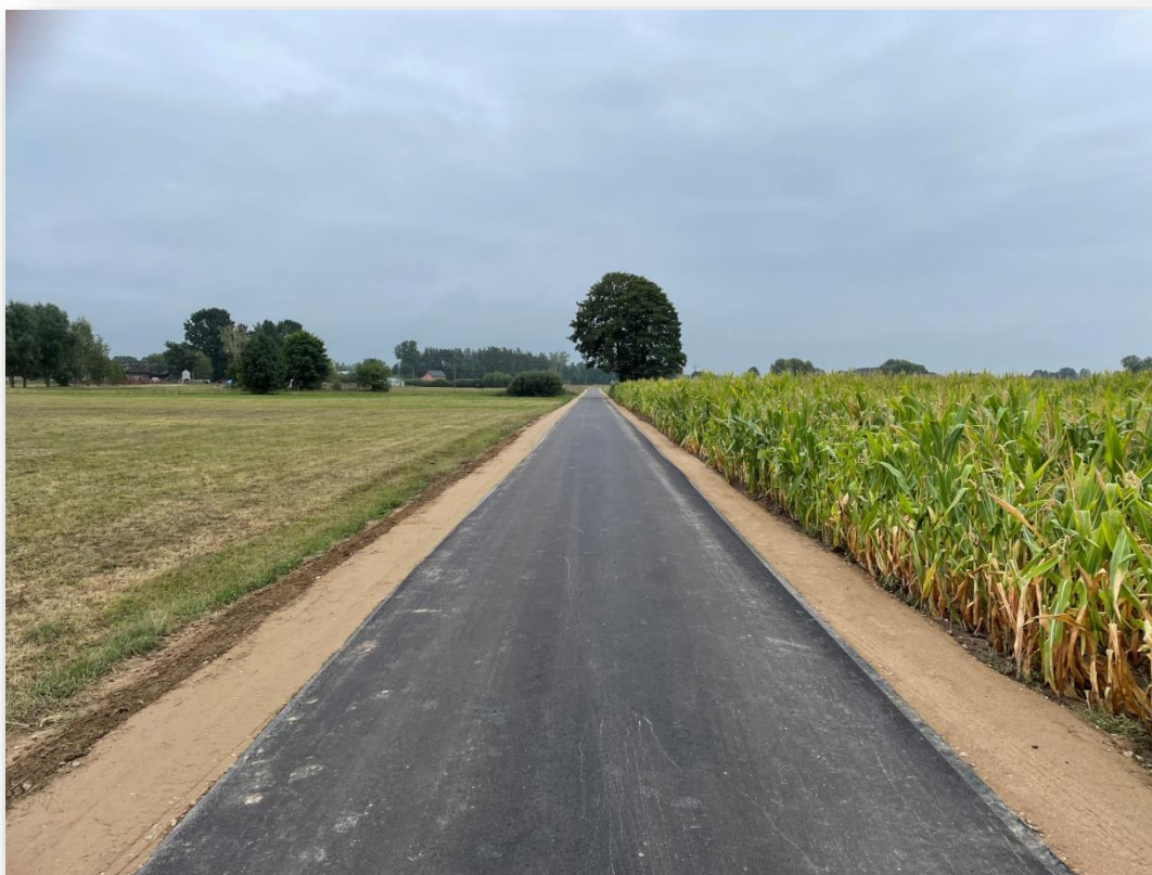
zdjęcie - droga w msc. Zawady
